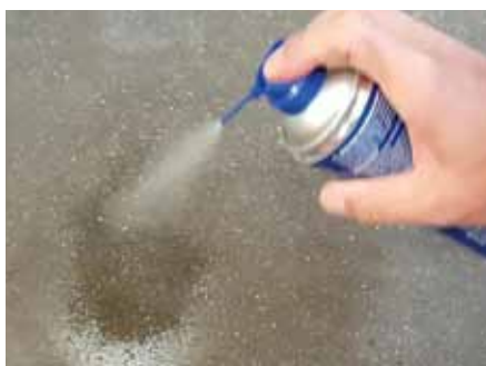
Vloer vetvrijmaken met industriële ontvetter
